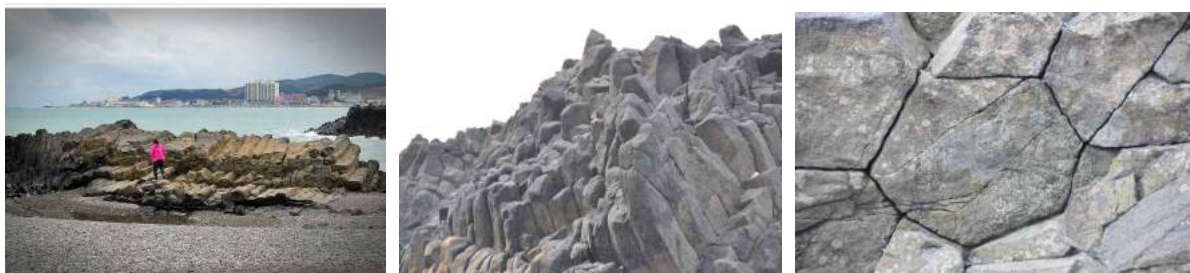
강동화암마을 주상절리 전경 및 근접사진
